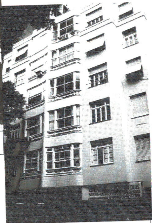
Edifício Alagoas Rua Ministro Viveiros de Castro, 122
