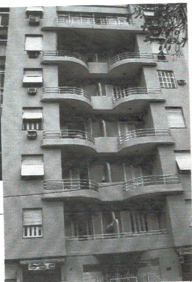
Edifício Lamberti Praça Serzedelo Correia, 15
