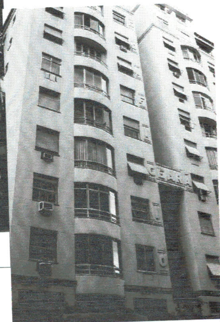
Edifício Ceará Av. N. Sra. Copacabana, 209
