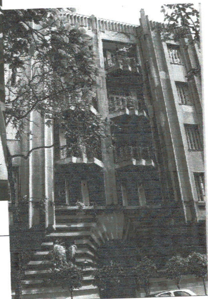
Edifício Guahy Rua Ronald de Carvalho, 181
