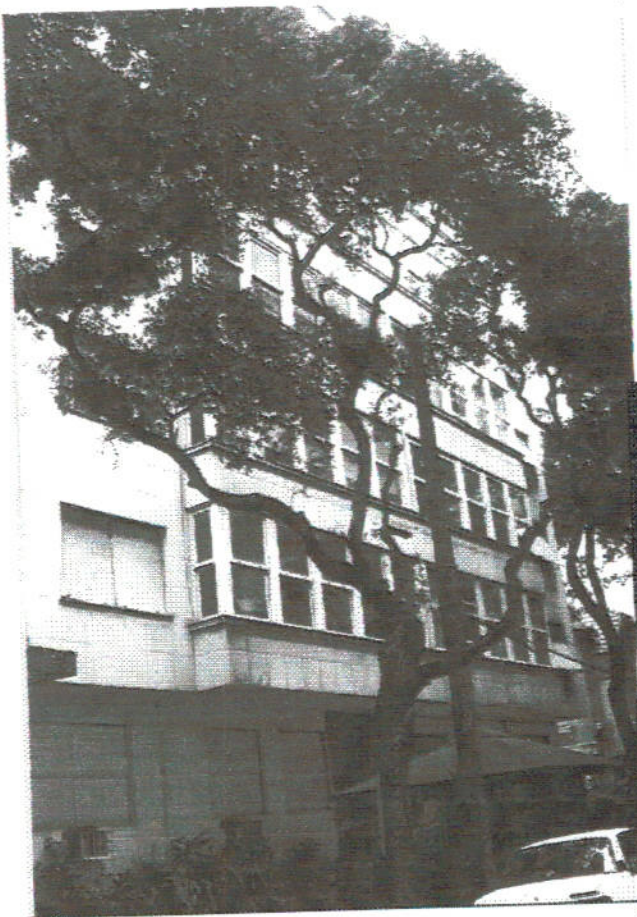
Edifício Acayaca Rua Sousa Lima, 149
