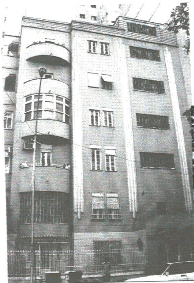
Edifício Palacete Piratininga Av. Rainha Elizabeth, 152
