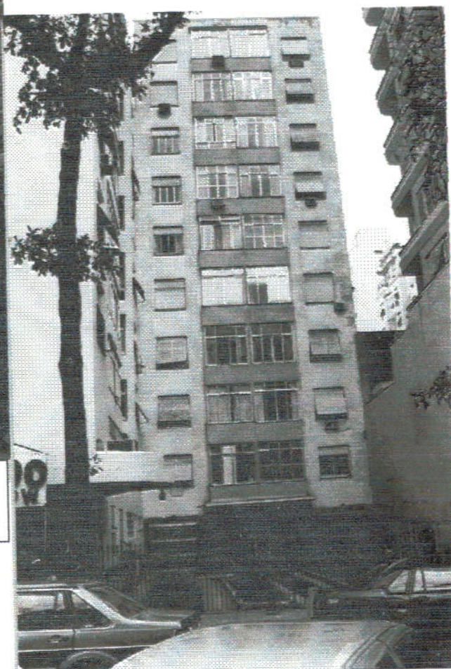
Edifício Ribeiro de Almeida Rua Ronald de Carvalho, 45
