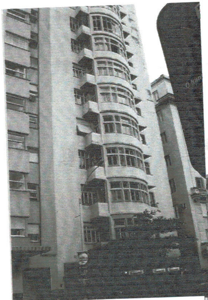
Edifício Comodoro Av. N. Sra. Copacabana, 162
