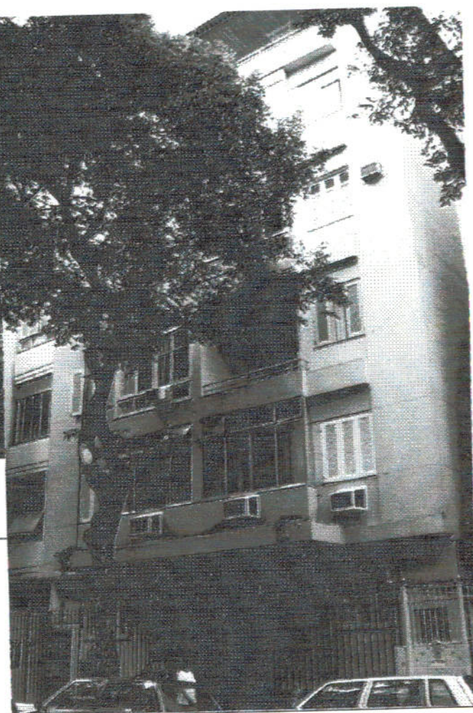
Edifício Orion Rua Ministro Viveiros de Castro, 104
