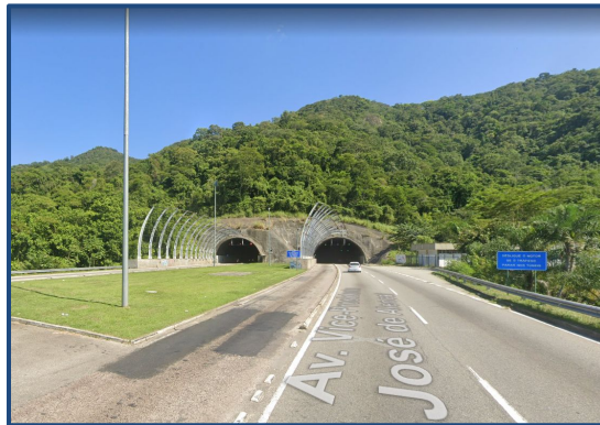
Túnel da Grota Funda
