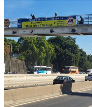
Instalação de Faixas
