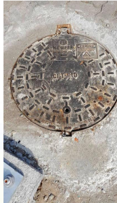
Instalação de caixas antifurto
