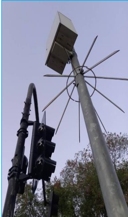
Equipamentos no alto e instalação de garras antifurto
