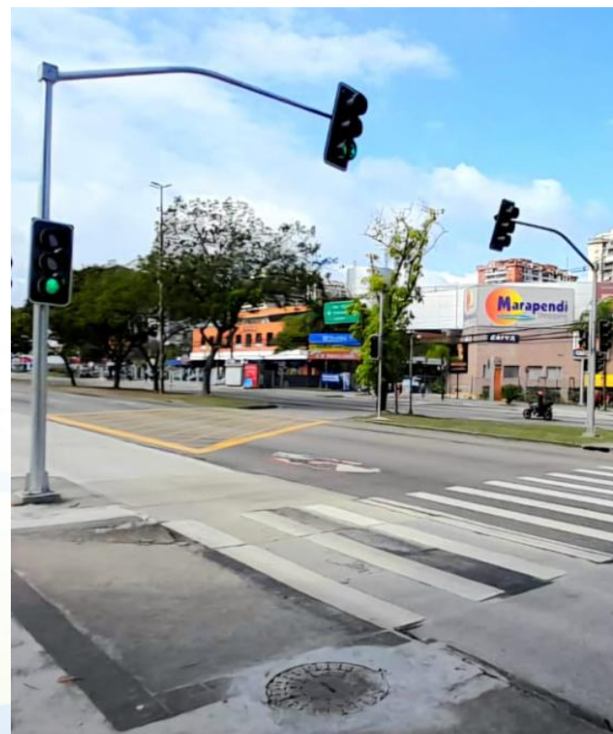
Instalação de novos semáforos
