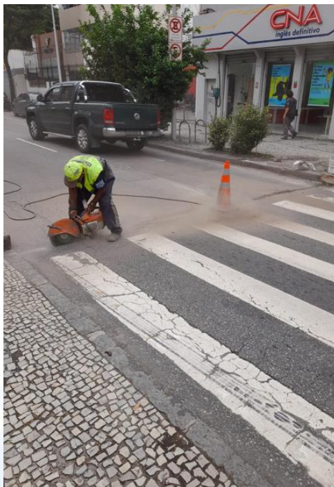
Cabos enterrados no solo
