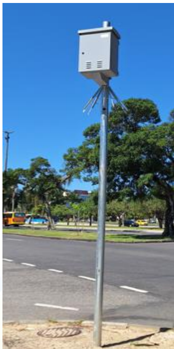
Equipamentos no alto e instalação de garras antifurto
