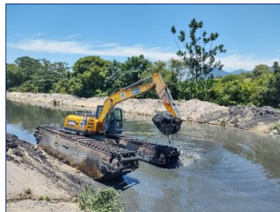
RIO CABUÇU PIRAQUÊ – Avenida DOM JOÃO VI
