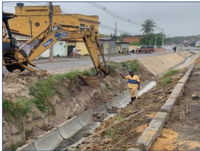
CANAL DA AVENIDA PAULO AFONSO – CAMPO GRANDE
