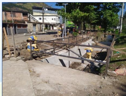
OBRAS DE MICRODRENAGEM DA RUA HELIANTO E RECUPERAÇÃO DA PAREDE LATERAL DO RIO CATARINO, NA PRAÇA DO SKATE – PADRE MIGUEL
