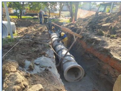
OBRAS DE MICRODRENAGEM DA RUA HELIANTO E RECUPERAÇÃO DA PAREDE LATERAL DO RIO CATARINO, NA PRAÇA DO SKATE – PADRE MIGUEL
