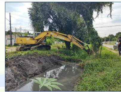
CANAL DOIS – AVENIDA ALTO MARANHÃO – GUARATIBA
