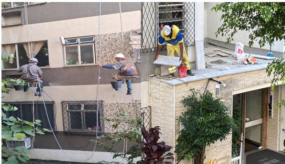
Conjunto Maravilha Parque Gabinal
