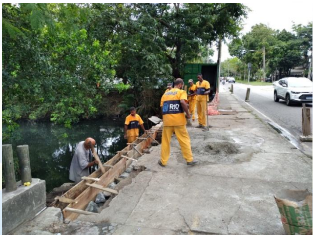
Manutenção AP 4 ponte na Avenida Gláucio Gil - Recreio dos Bandeirantes
