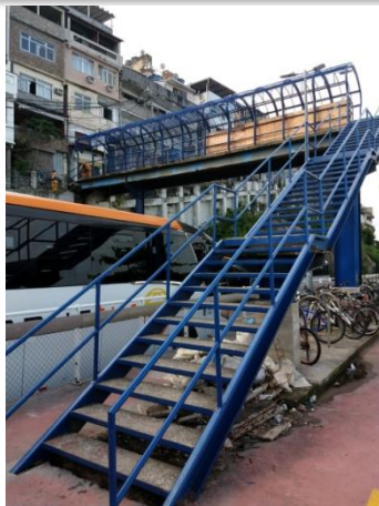
Manutenção AP 1 e 2 Passarela sobre a Av. Niemeyer
