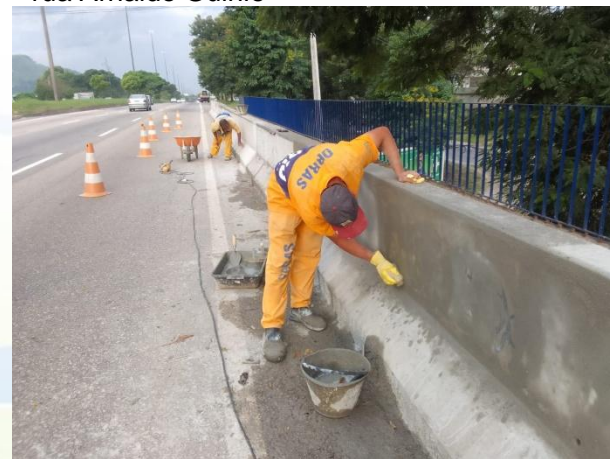
Manutenção AP 5 viaduto sobre a estrada do Mendanha na Avenida Brasil
