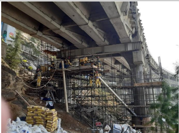
Manutenção do Elevado das Bandeiras
