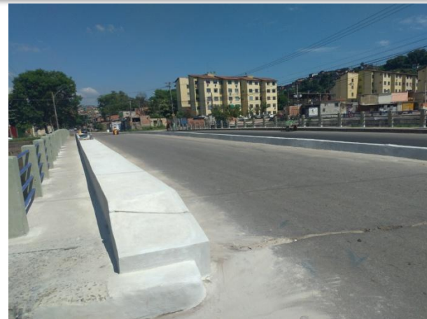
Manutenção AP 3 Ponte sobre o Rio Acari na rua Arnaldo Guinle
