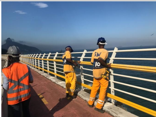
Substituição de guarda corpo, ciclovia Tim Maia - Barra da Tijuca / São Conrado.
